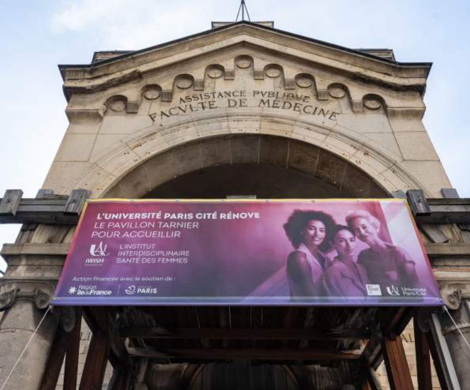
La façade du bâtiment Tarnier, en cours de rénovation / The facade of the Tarnier building, undergoing renovation © Maximilien Sporschill
